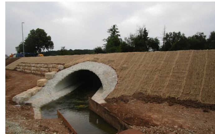
Neuer Wellstahldurchlasses
