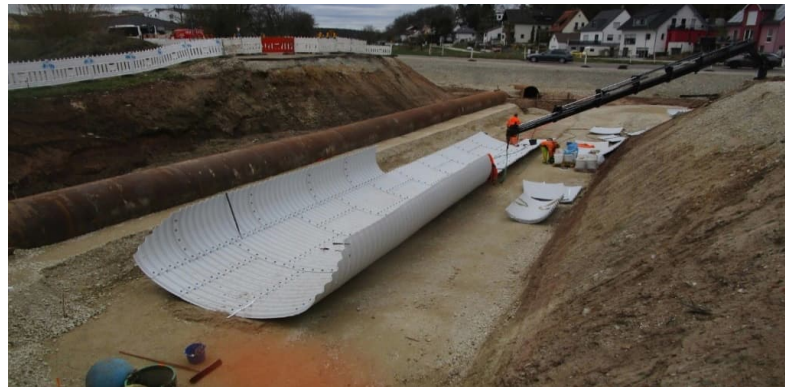
Aufbau des neues Wellstahldurchlasses
