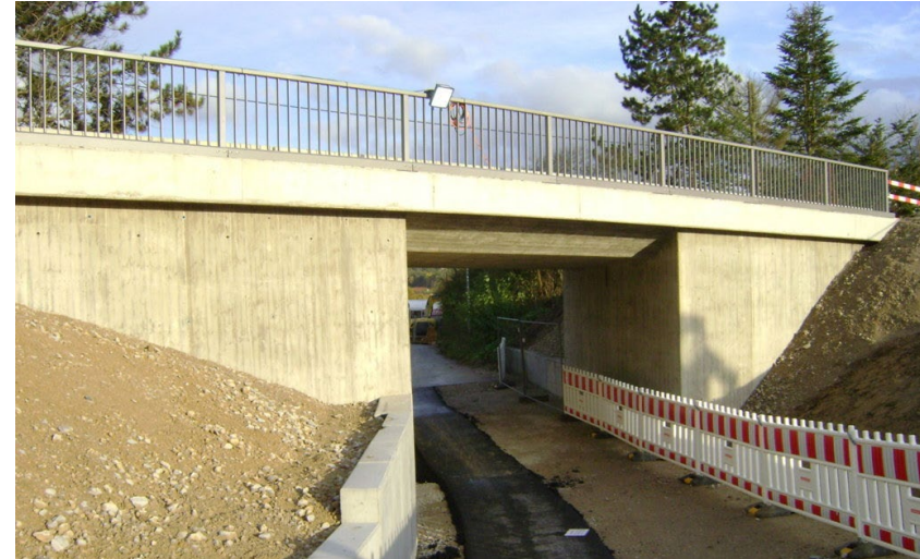
EÜ km 10,896 Schleifweg (2019)
